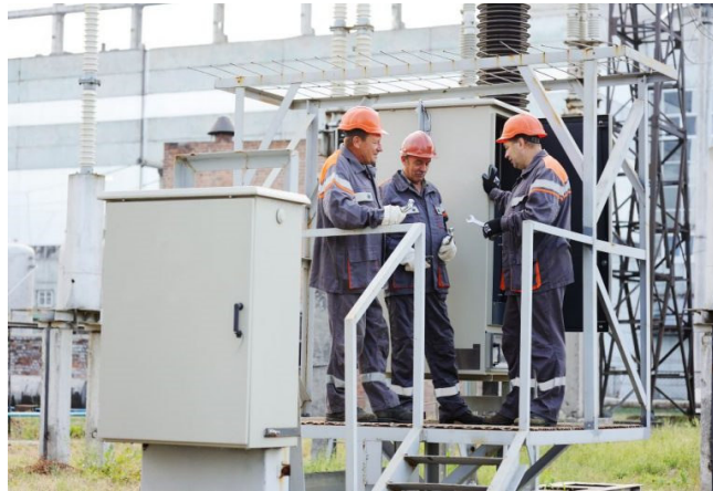
Fig. 05 – Utilização dos Equipamentos de Segurança
