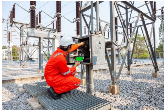
Fig. 01 – Manutenção eficiente em redes elétricas
